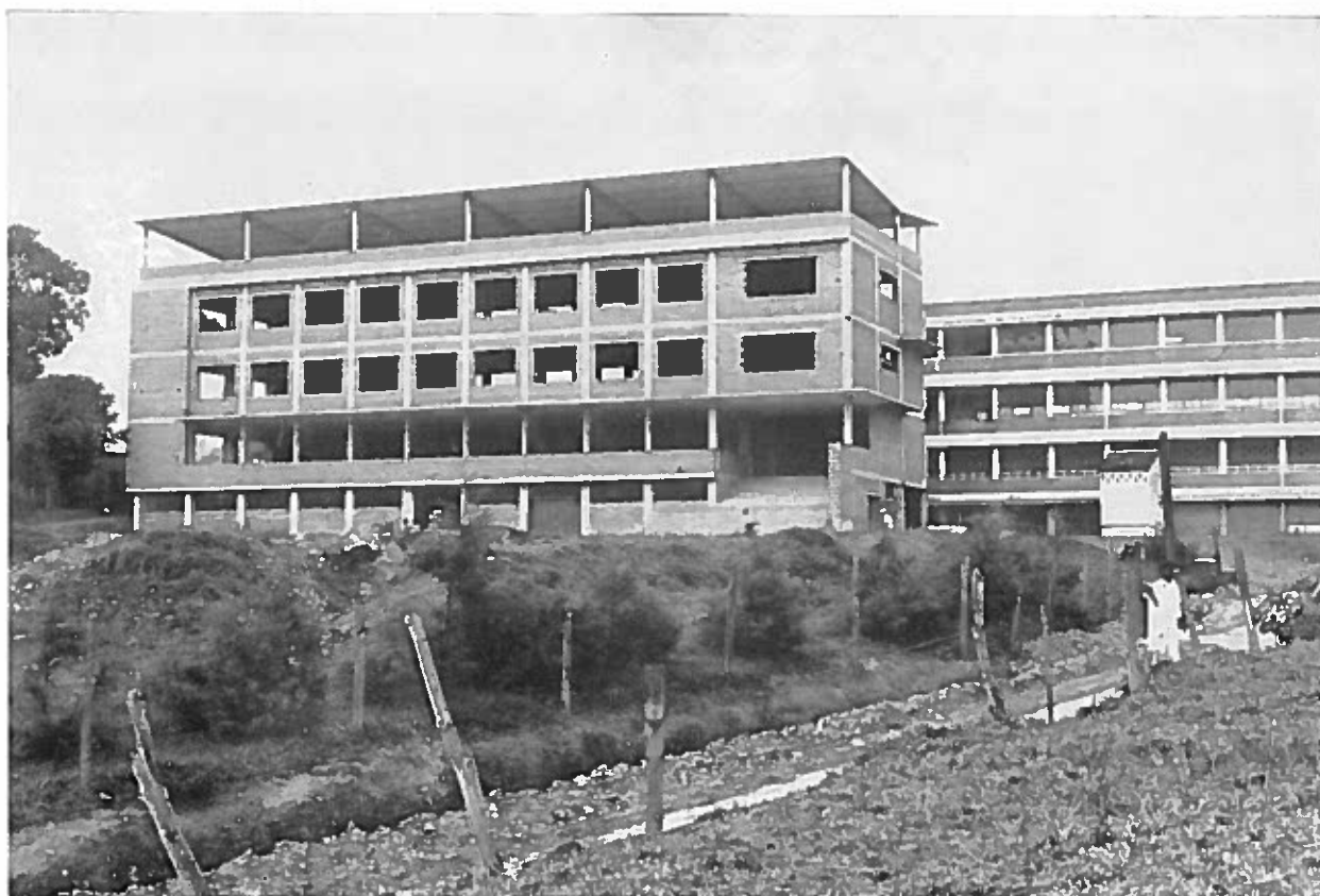
La Estrella: Neubau 1958; der unterste Stock ist inzwischen schon bezogen - New buildings 1958; lowest floor already occupied.
