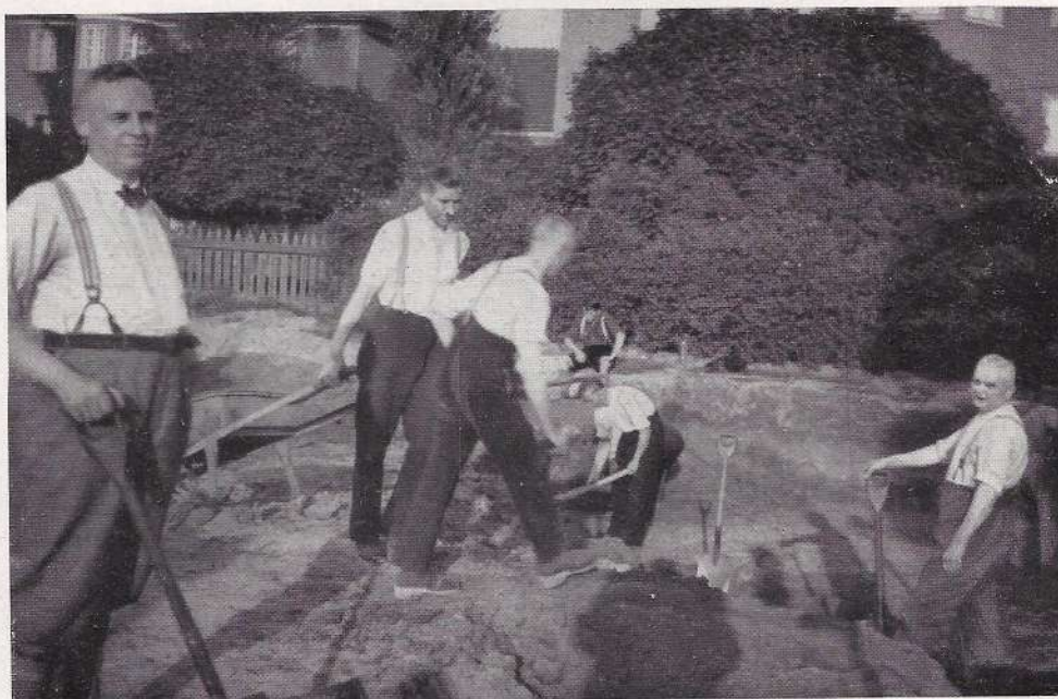
Akademiker beim Graben der Fundamente zur Salvatorkirche Berlin-Schmargendorf
