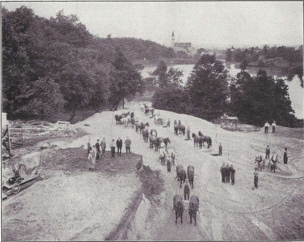
St. Nazianz. Beginn der Arbeiten für das neue Power-House mit Schwesternwohnung und Wäscherei. Dahinter unser See und der Ort St. Nazianz mit der Pfarrkirche.
